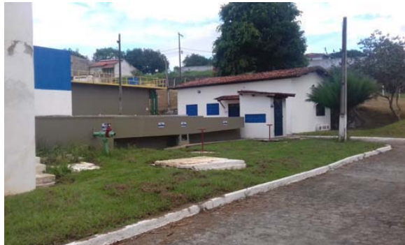
Foto 05: Vista da ETA.
