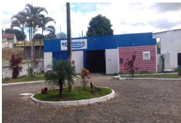
Foto 01: Casa de Química e Depósito – ETA.
